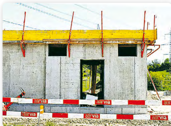
Druckreduzier- und Messstation im Rohbau
