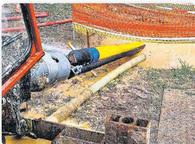
Einzug der Gasleitung in die Spülbohrung
