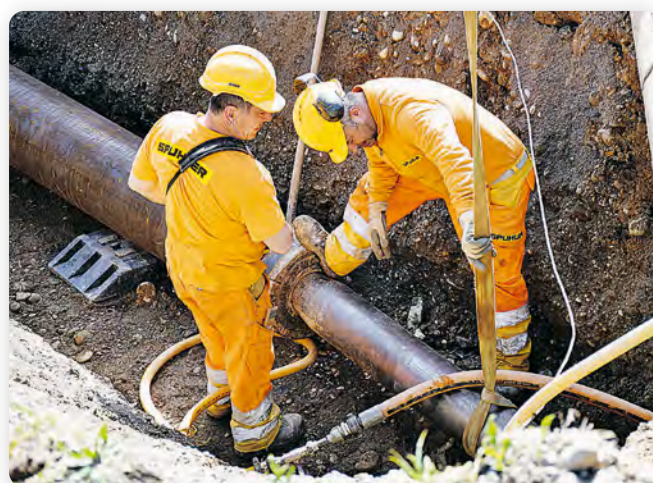
Rammung unter der Kantonsstrasse
