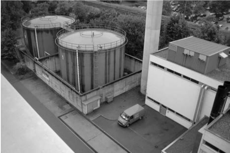
Reserveheizwerk der ABB in Turgi – vor dem Umbau der Tankanlage. Die Tanks stehen in Relation zum durch Refuna eingesparten Öl.
