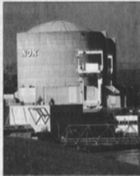
KKW Beznau Mit der Rohrbrücke für die Fernwärme der Refuna. NOK
