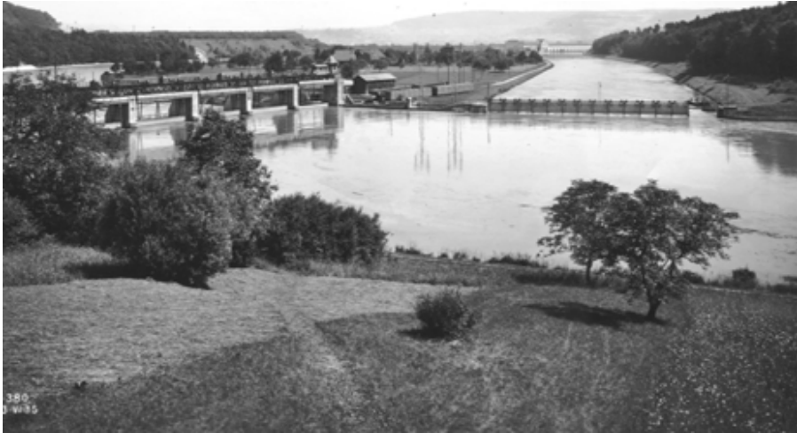
Beznau-Insel mit Einlaufschützen und so genannter „Rölleli“-Brücke (1935)
