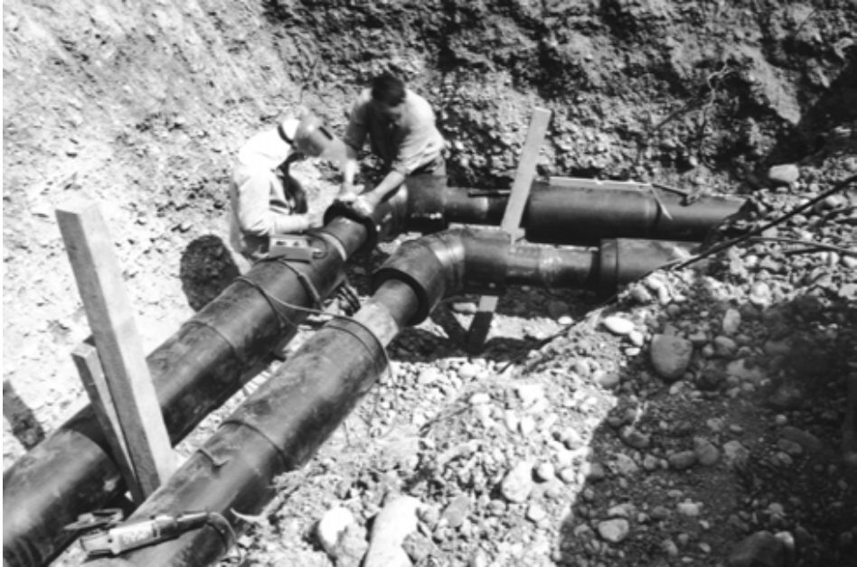
Bau des Refuna-Hauptnetzes, Vor- und Rücklaufleitung
