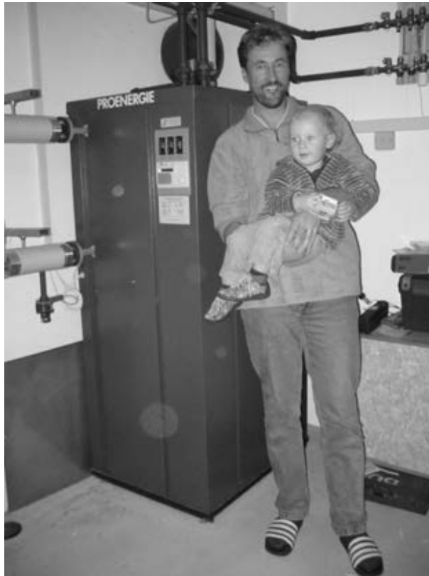
Karl Hämmerli mit seinem Sohn im Heizungskeller seines Hauses
