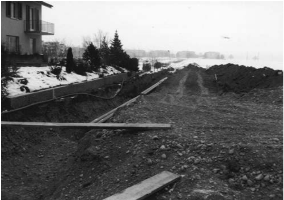
Bau der Transportleitung von Kleindöttingen nach Leuggern
