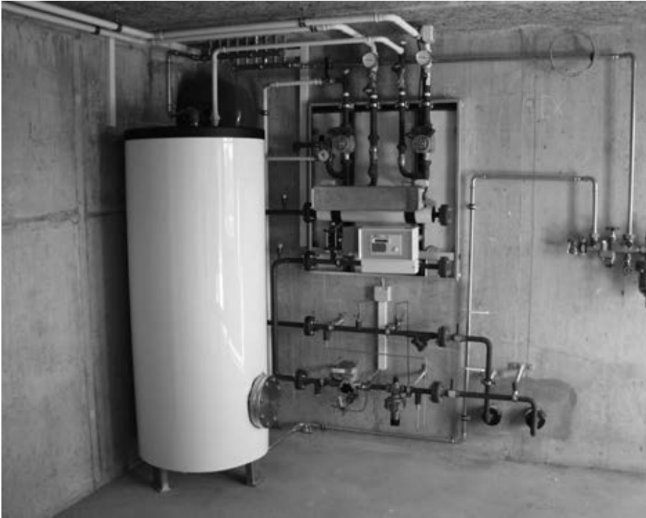
Eigene Hausstation der REFUNA AG ohne Abdeckung (Familie Buecheler, Klingnau)
