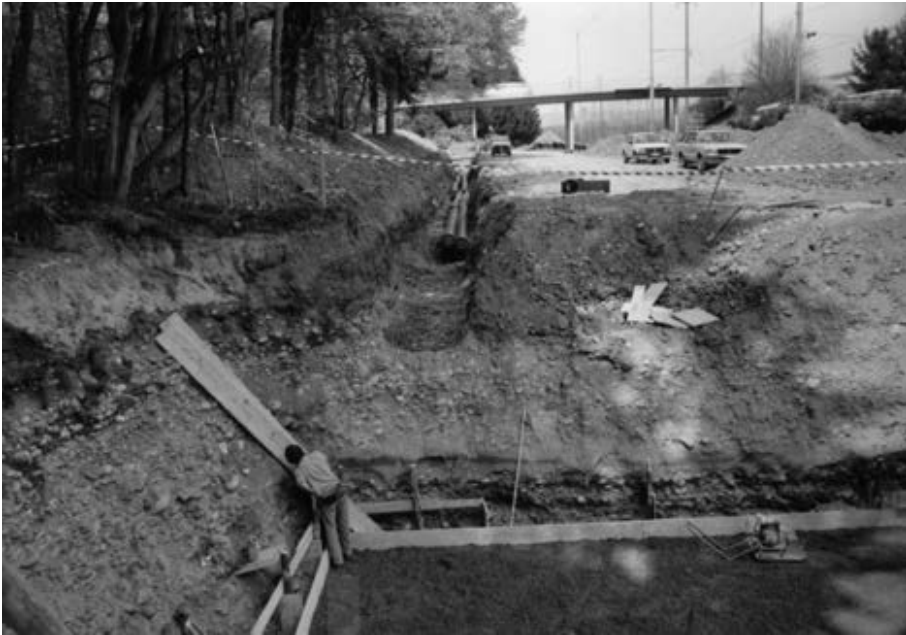
Erste Baumassnahmen für die Pumpenstation an der Granella-Kreuzung in Würenlingen
