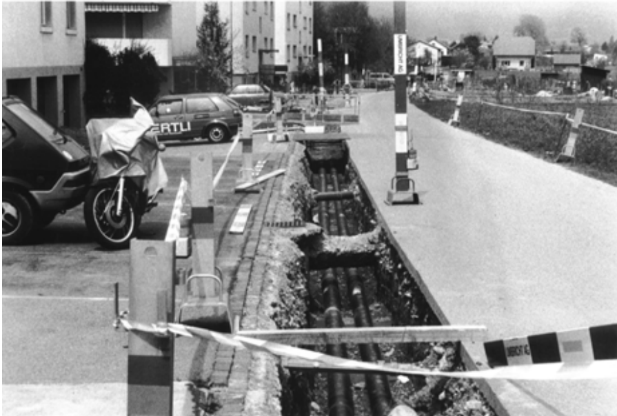
Baustelle im Ortsnetz Riniken
