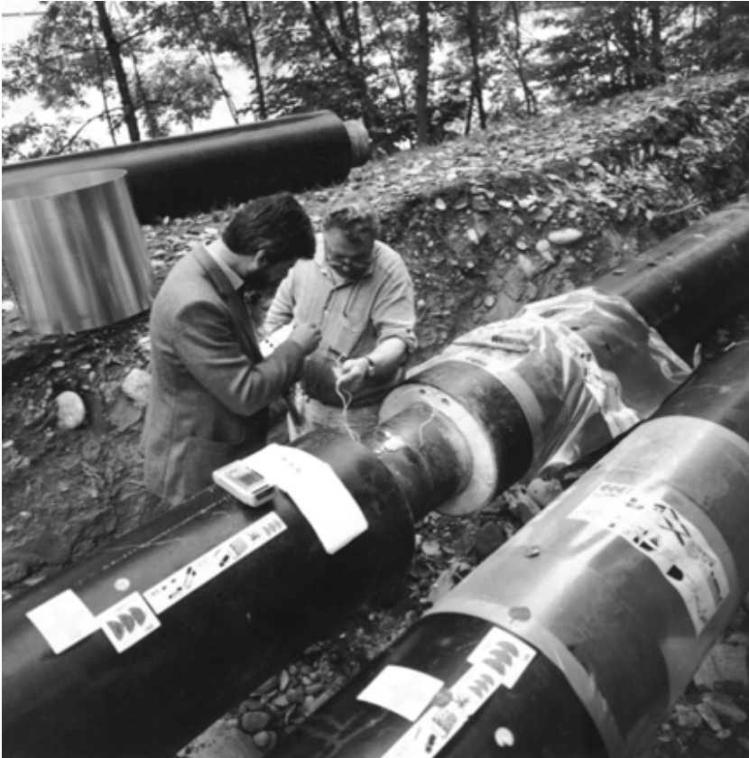
Montage der Drähte des Leck-Überwachungssystems an den Rohren des Hauptnetzes
