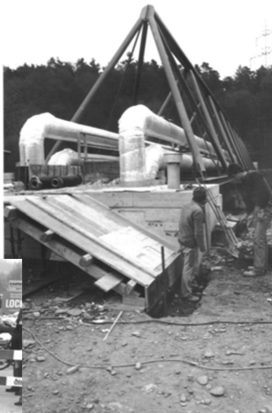
Oben: Rohrbrücke über die Aare für die Leitungen des Hauptnetzes beim KKW Beznau
