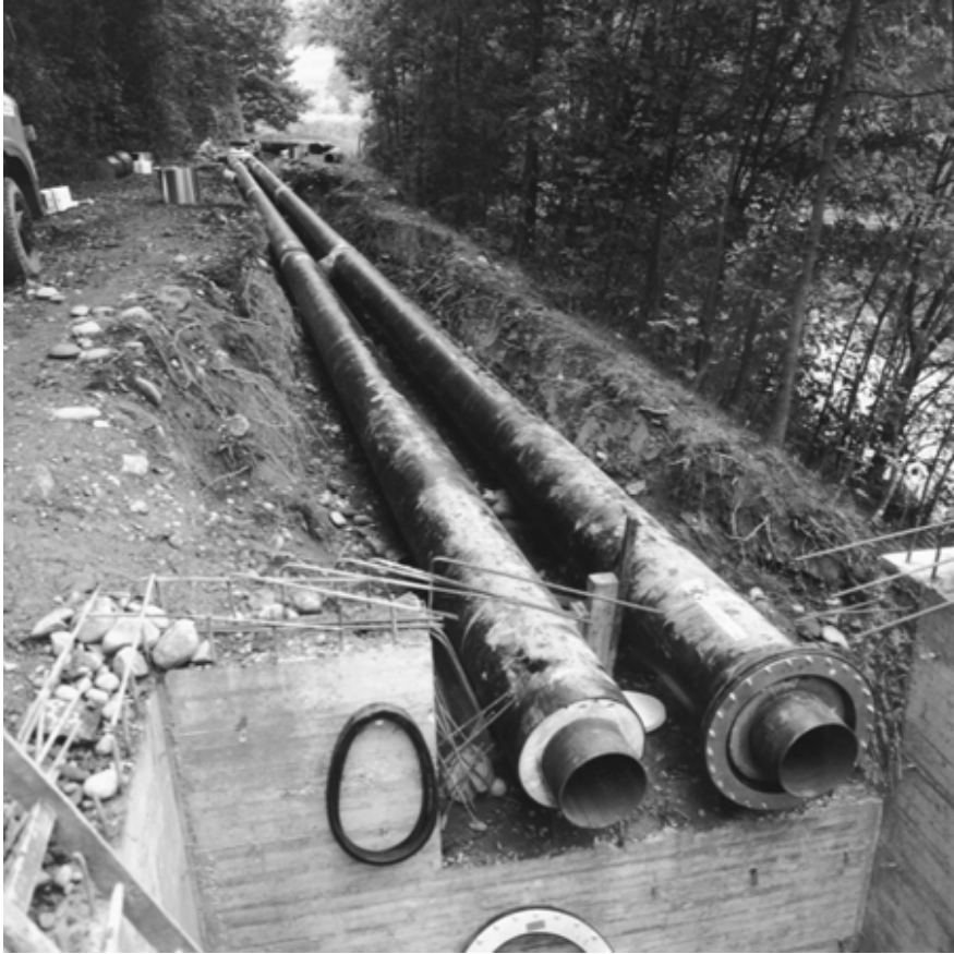
Bau der Fernwärmeleitungen vom KKW Beznau zu den Bundesinstituten EIR/SIN
